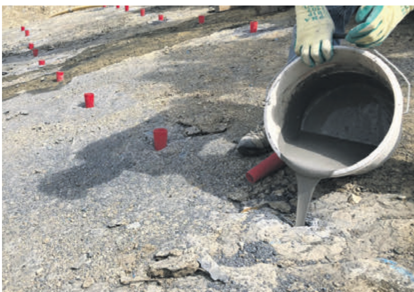
In vorab gebohrte Löcher wird Betonamit gefüllt. Vier Stunden später entstehen Risse. Das Material kann entfernt werden.
